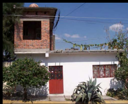
Una vivienda de construcción más sólida, resultado de la consolidación de un lote en un asentamiento humano irregular.
