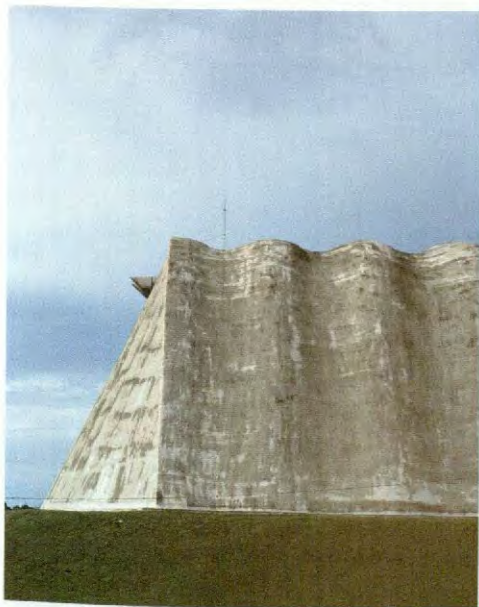
34 Navios silo, Nueva Palmira. Interior
