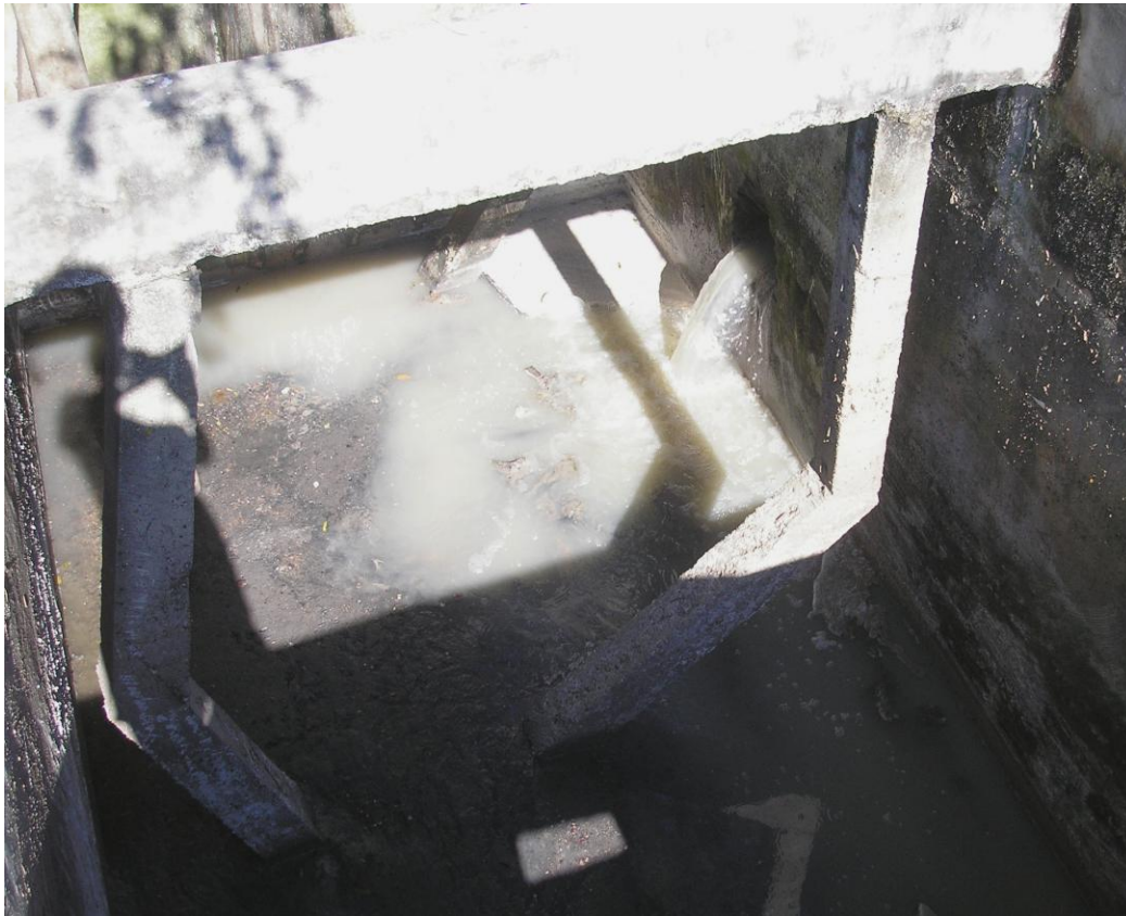
Figure 4 Incomplete Sedimentation Chamber in Barrio El Llano del Conejo
