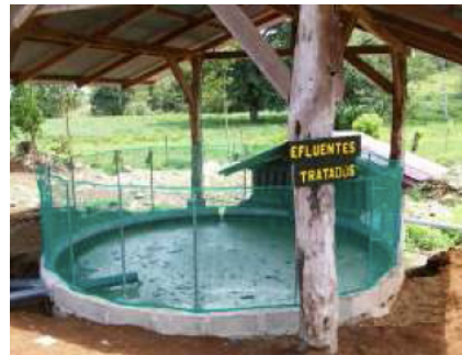
Effluent collection tank
